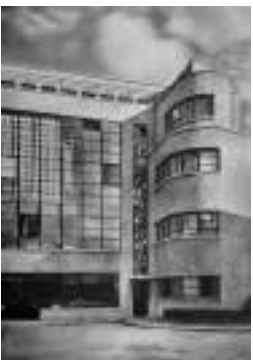
[fig.30] un vitrage courbé pour éclairer un atelier de manière homogène
