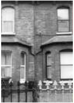
[fig.41] mise en commun d'une descente d'eau et d'une barrière
