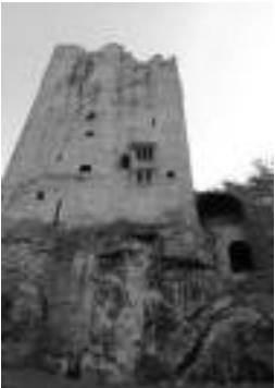
[fig.5] situé sur les hauteurs de la ville, le donjon contrôle l’horizon
