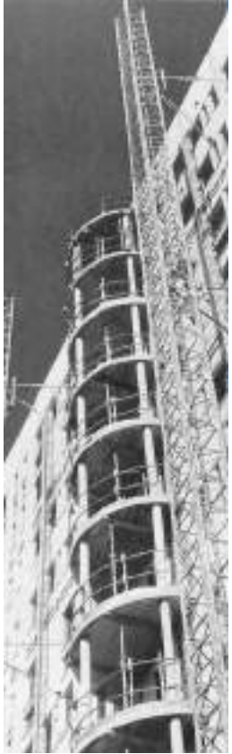
[fig.36] un ajout post-construction en façade sans déranger les habitants
