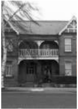
[fig.42] partage du toit, d'un balcon, d'un porche et d'un seuil d'accès
