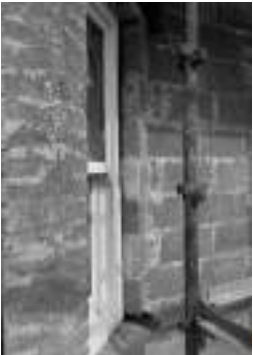
[fig.15] meneaux épais mais fragiles réalisés en briques de béton coupées
