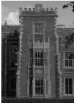
[fig.17] un mur dimensionné pour sa baie réalisé avec les mêmes matières
